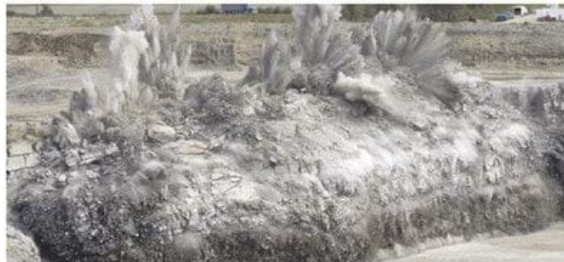
شکل ۹ بهسازی خاک به روش انفجار
