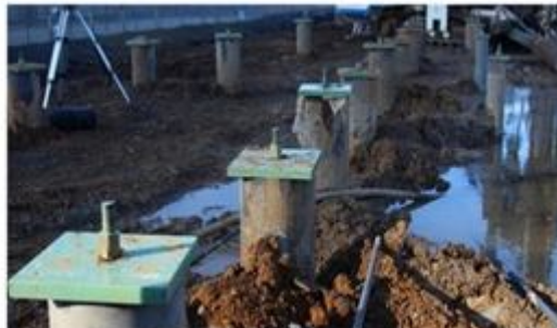
شکل ۵ بهسازی خاک به روش میکروپایل
