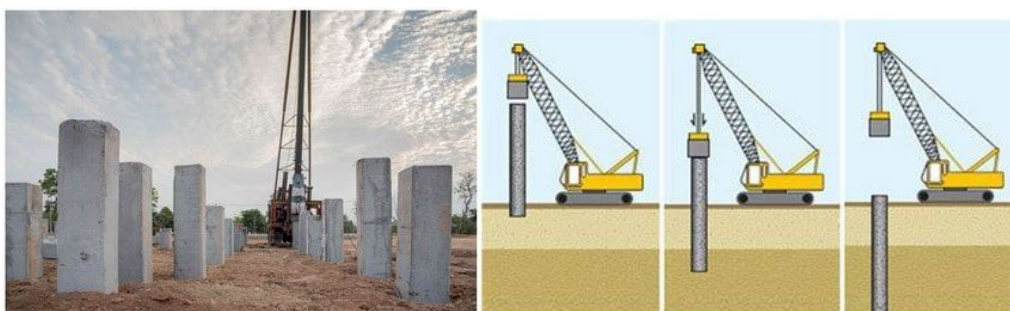
شکل ۱۱ اجرای شمع بتنی پیش ساخته
