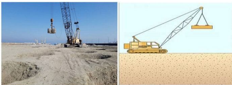
شکل ۷ بهسازی خاک به روش تراکم دینامیکی شکل ۸ بهسازی خاک به روش تراکم دینامیکی
