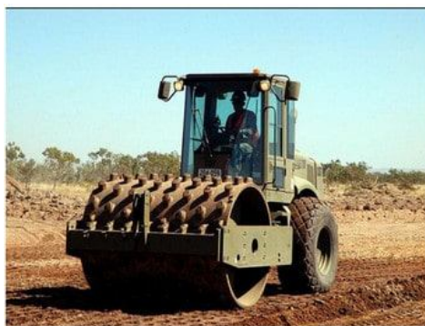
شکل ۶ بهسازی خاک به روش تراکم سطحی
