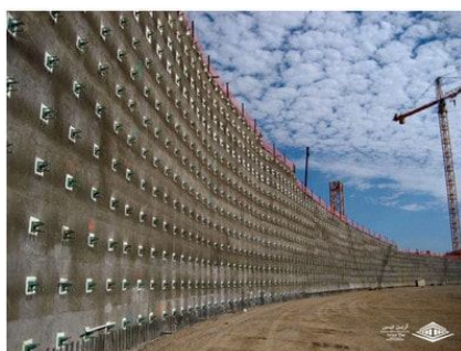
شکل ۱۲ بهسازی خاک به روش نیلینگ
